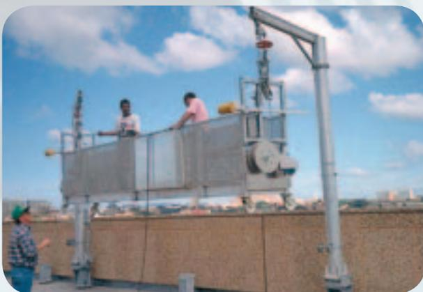
**Шлюпбалки с электропитанием** представляют собой промежуточную систему между фиксированными шлюпбалками и машинами по обслуживанию зданий. Передвигаясь по вертикальной плоскости, с креплением на парапете, данная система не требует установки какого-либо оборудования на кровле, при этом режим работы остается простым и эффективным.
