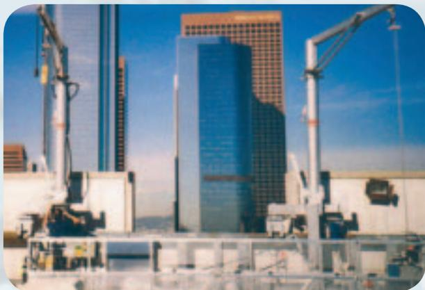
В основе первой системы – люлька, подвешенная на двух **фиксированных шлюпбалках**. Возможность регулирования и небольшой вес (изготовлено из алюминиевого сплава) обеспечивают очень экономичное решение и простоту монтажа. Система обеспечивает посекционный доступ ко всем частям фасада соответственно длине люльки, которая оборудуется подъемным механизмом и катками, с электрическим приводом.
